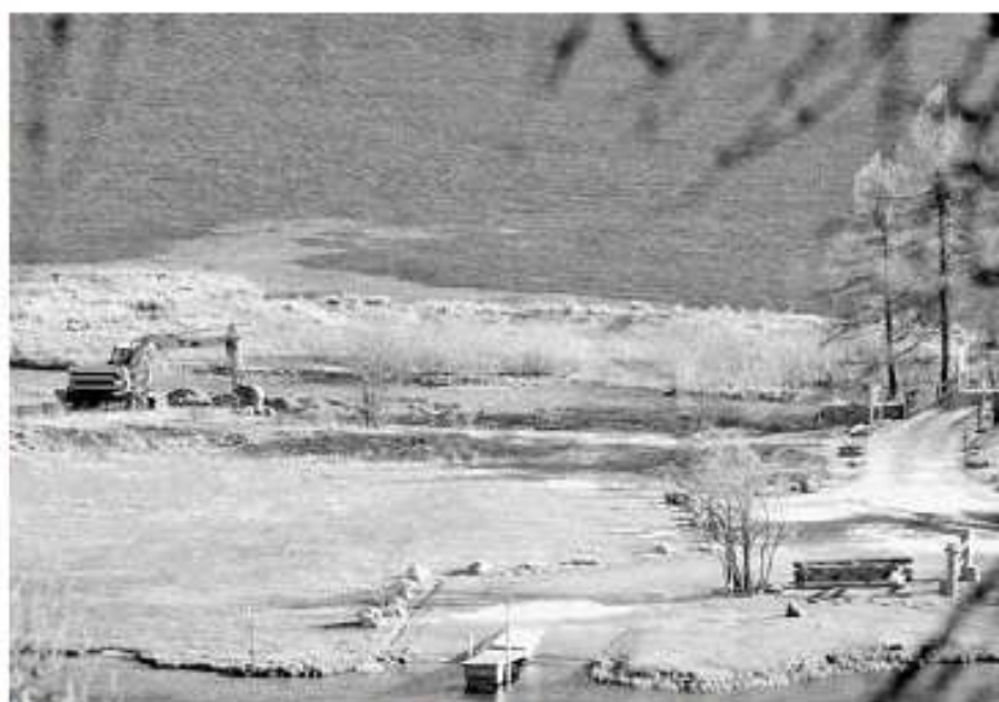
Baggerarbeiten im Dienst der Ökologie: Während die Mündung des Fexbaches linksufrig leicht verstärkt wird, sorgt ein abgetragener Wall auf der rechten Seite für die Überflutung des Deltas Richtung Süden.
