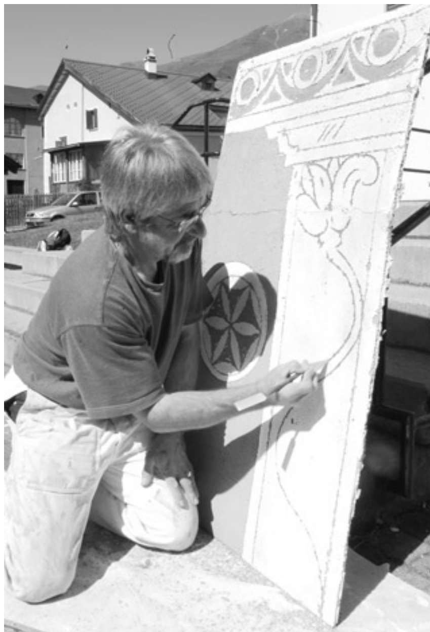
Einem Sgraffito-Künstler zugeschaut: Paulin Nuotclà ritzt mit dem Stukkaturmesser ein Blumenmotiv durch die Kalkschicht in den Deckverputz.
